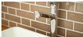
カフェ風のキッチンタイル
